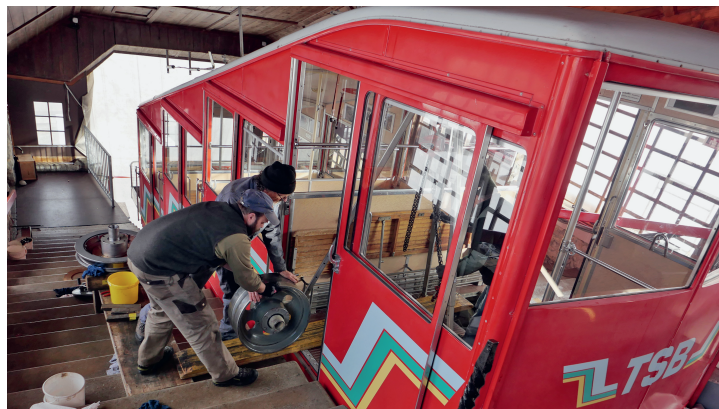
Nach umfassender Kontrolle der Einzelteile werden das Walz- und Spurrad der Bergbahn wieder eingesetzt.
